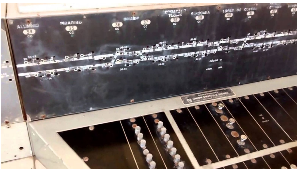
Figura 40: painel do CTC da Estrada de Ferro Sorocabana em Sorocaba.
