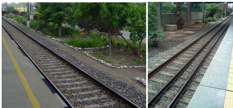
Figuras 54 e 55: Estação Cidade Universitária: a via sentido Grajaú (esquerda) não possui bitola mista, ao passo que a via sentido Osasco (direita) a possui.
