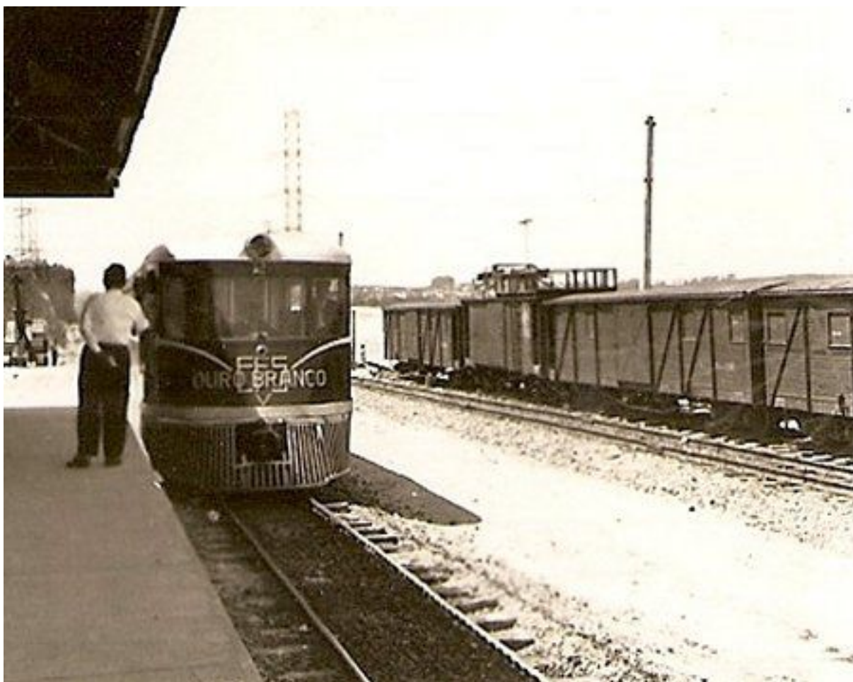
Figura 13: trem unidade diesel-elétrico Ouro Branco, que fazia a linha São Paulo – Peruíbe, na estação Cidade Dutra, logo após a abertura do ramal. Notar a inexistência da eletrificação.
