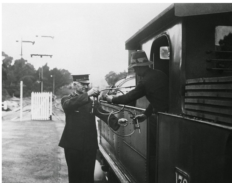
Figuras 31 e 32: aparelho de staff inglês e troca de bastões em uma estação australiana, respectivamente. Fontes: Grace's Guide to British Industrial History e Johnny's Pages, respectivamente.
